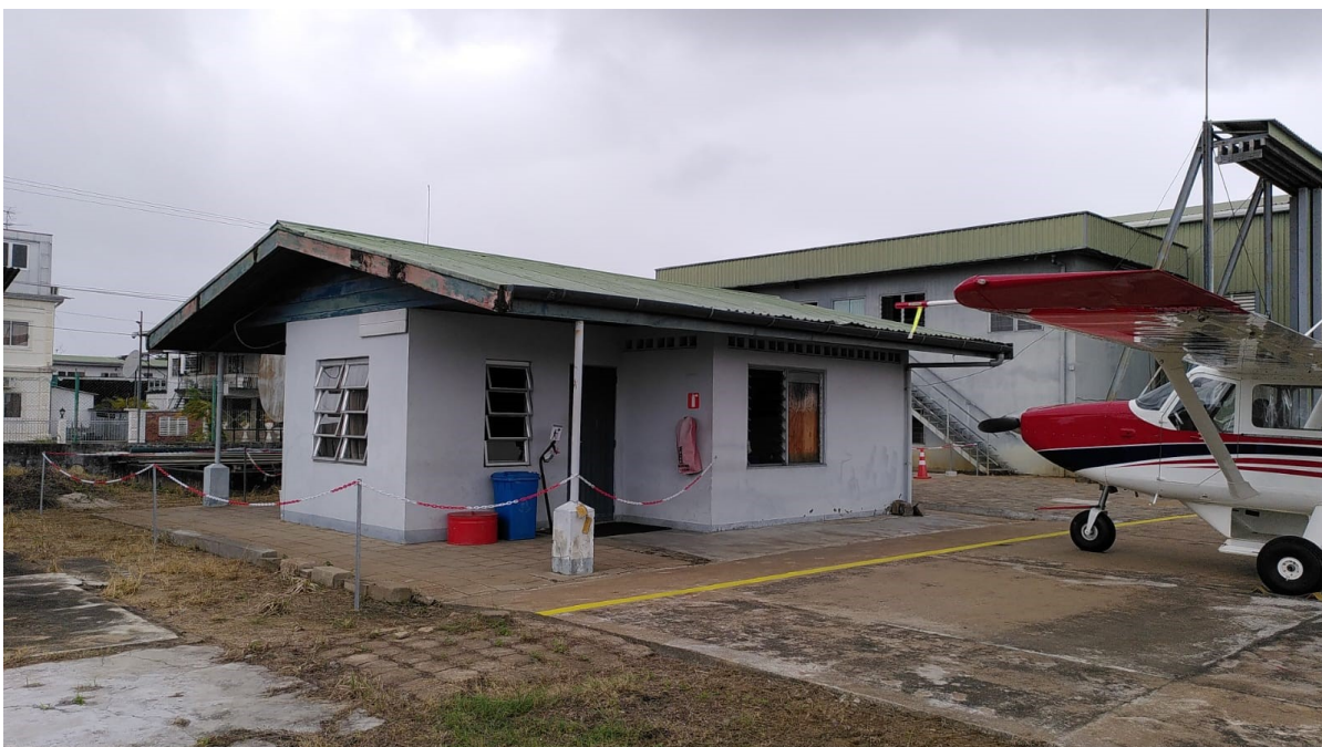
MAF's tijdelijk onderko- men. Op de voorgrond de incheck- en passa- giersruimte en op de achtergrond de lucht- machthangaar.
